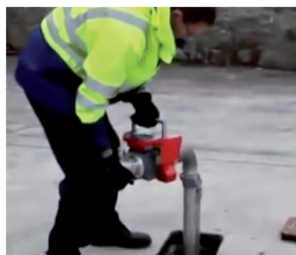
Stap 1: Monteer Flowmaster aan hydrant
